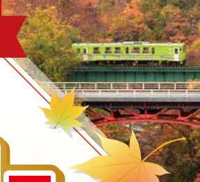
【秋田内陸縦貫鉄道】笑内駅～岩野目駅の鳥渡川橋梁
